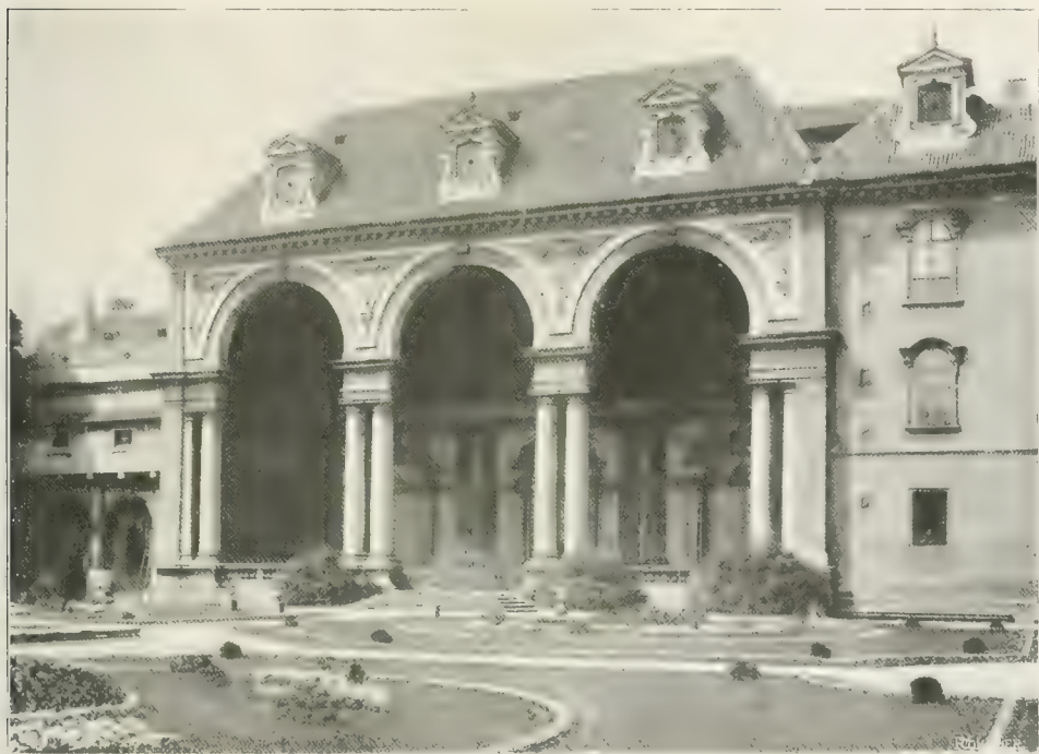
La loggia dans le parc du palais Wallenstein.
